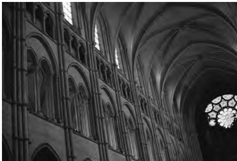
Fig. 67 Interior de la Catedral de Laon, Francia, donde se aprecia la bóveda de crucería.
