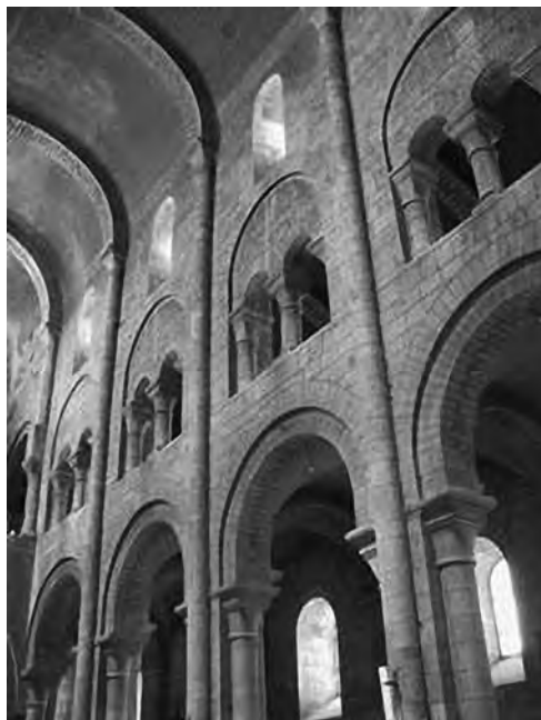
Fig. 47 Vista del interior de Saint Etienne, Nevers, Francia.
