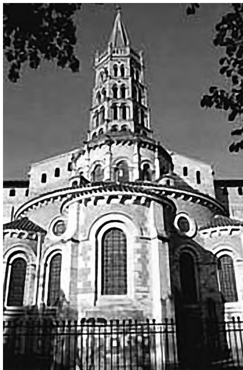
Fig. 45 Vista del ábside de Saint Sernin.
