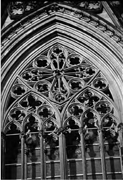
Fig. 74 Detalle de la tracería de una ventana ojival de la Catedral de Colonia.
